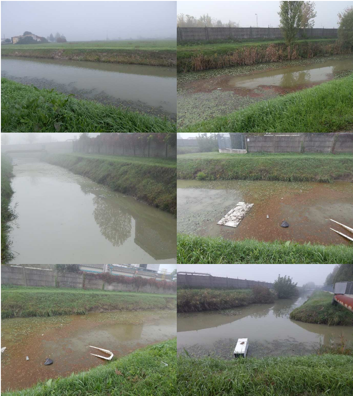
Allegato 2. Report fotografico relativo al sopralluogo presso il Canal Bianco, in Via delle Bonifiche, loc. Ferrara.
