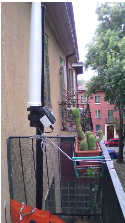
centralina monitoraggio continuo - balcone esterno, 4° piano
