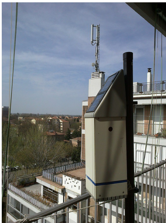
Centralina posta sul balcone 8° piano affacciato su via M.Poledrelli
