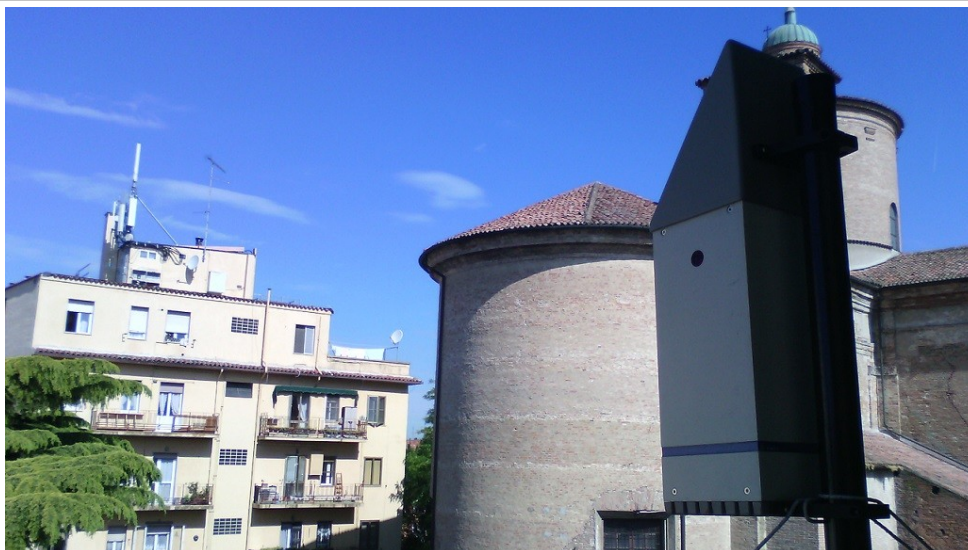
Centralina posta sul balcone esterno, 4° piano
