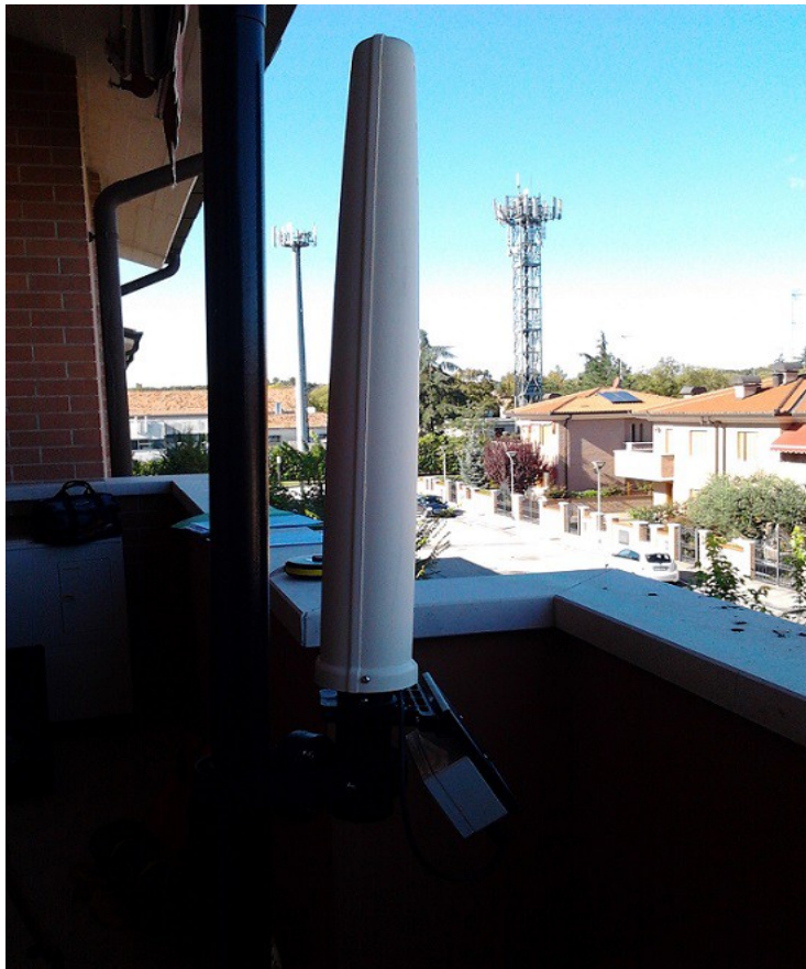
Centralina posta sul balcone esterno affacciato su via Rossellini
