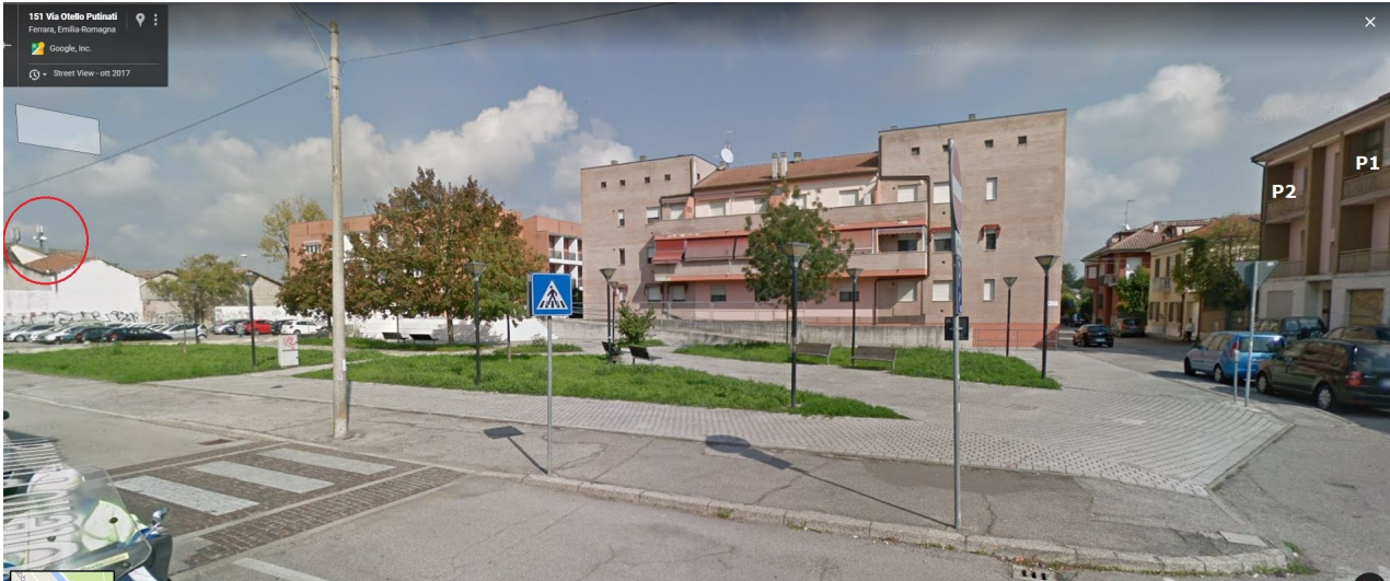
Punti di misura P1 e P2 sui due balconi . In rosso sono evidenziati gli impianti SRB
