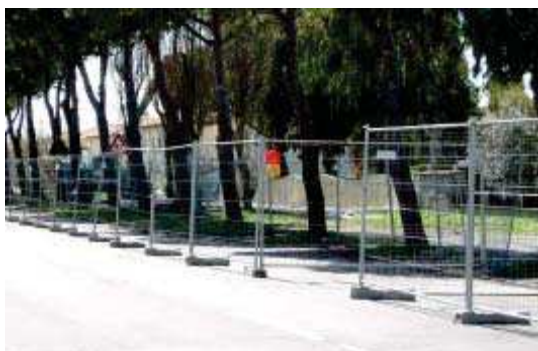
Esempio di recinzione con barriere mobili
